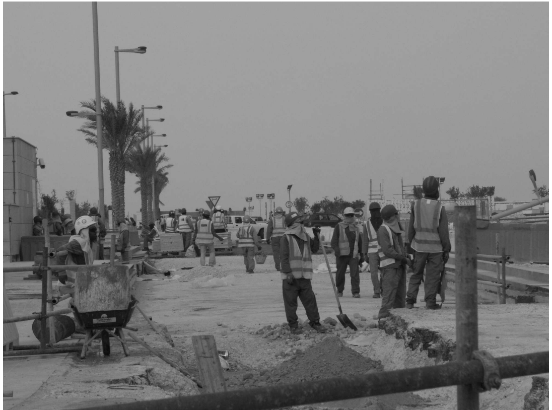
Bauarbeiter im Urbanisierungsprojekt Lusail City, Katar
